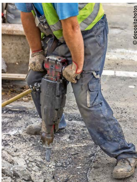
Auf Baustellen sind fast immer Mischstäube vorhanden mit problematischen Stoffen wie beispielsweise Quarzstaub.
